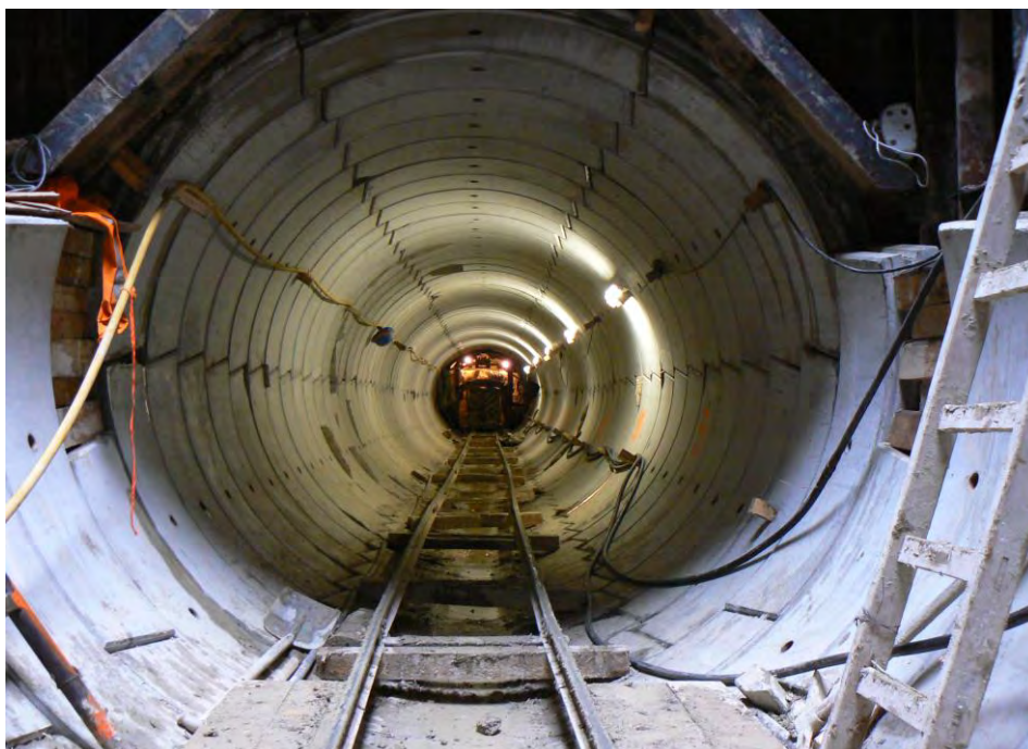
Obr. 6: Štítování ražba pod ochranou ocelového válce
