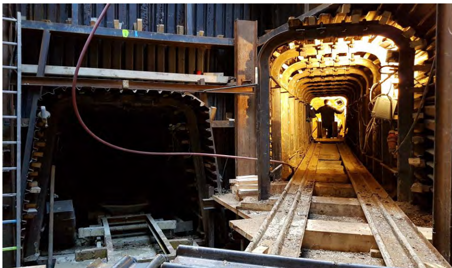
Obr. 5: Klasická štola prováděna hornickým způsobem
