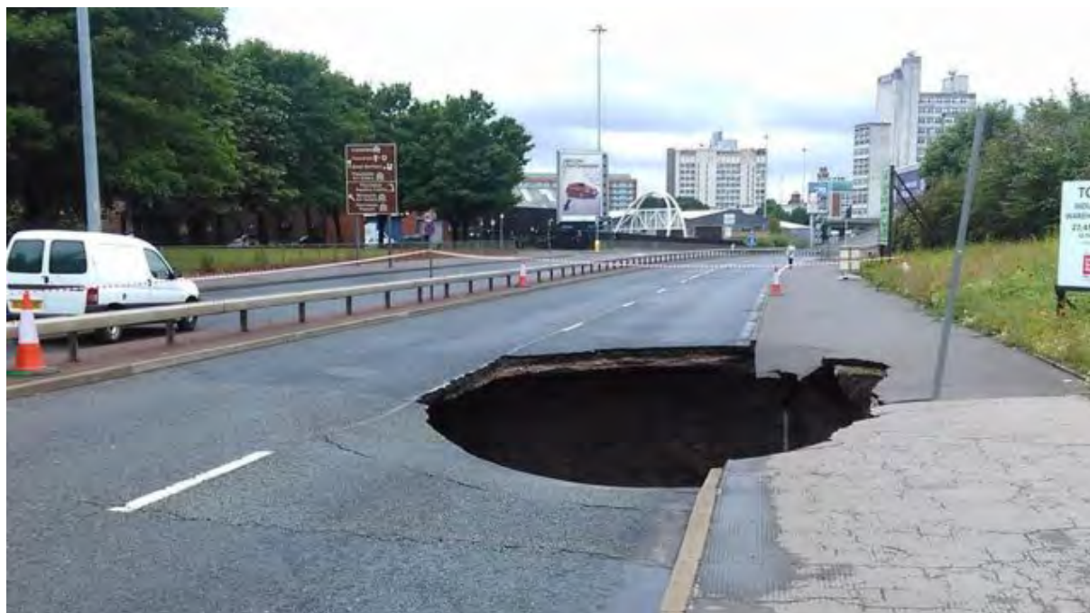
Obr. 4 – Důsledek kombinovaného vlivu otřesů a vibrací způsobených dopravou a dále vlivu netěsných vodovodů a kanalizací v intravilánech sídel (zdroj: internet).
