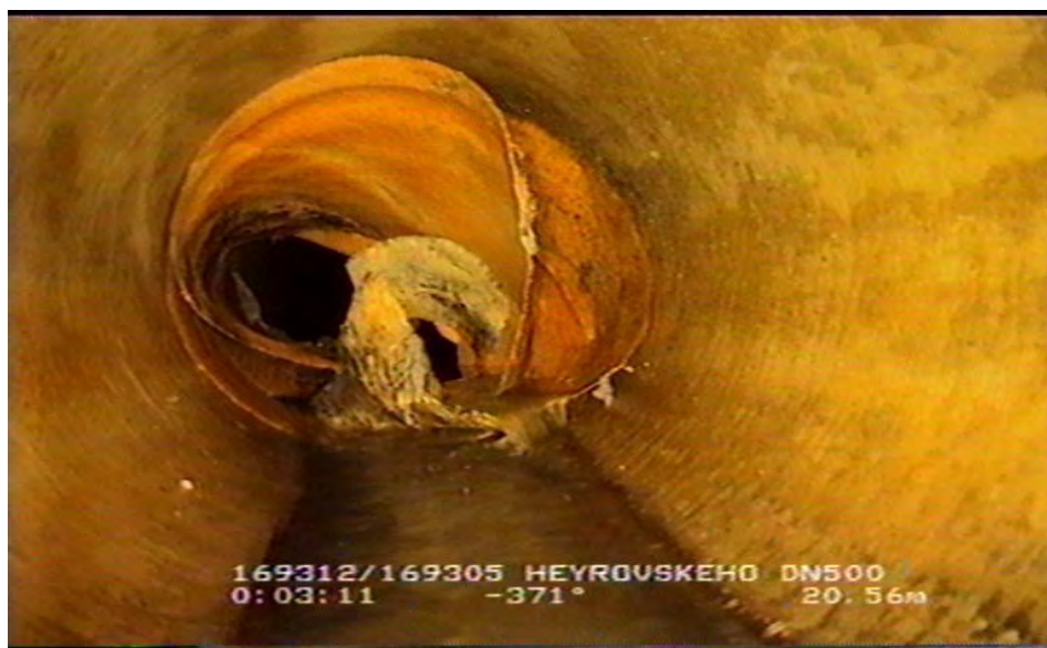
Obr. 2: Lokální závada, překážka shrnutí textilní vložky
