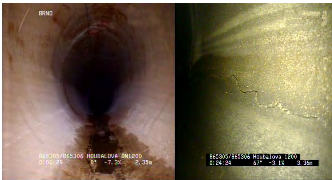
Obr. 3: Vložkování kanalizace geotextilním rukávem, původní lokální porucha
