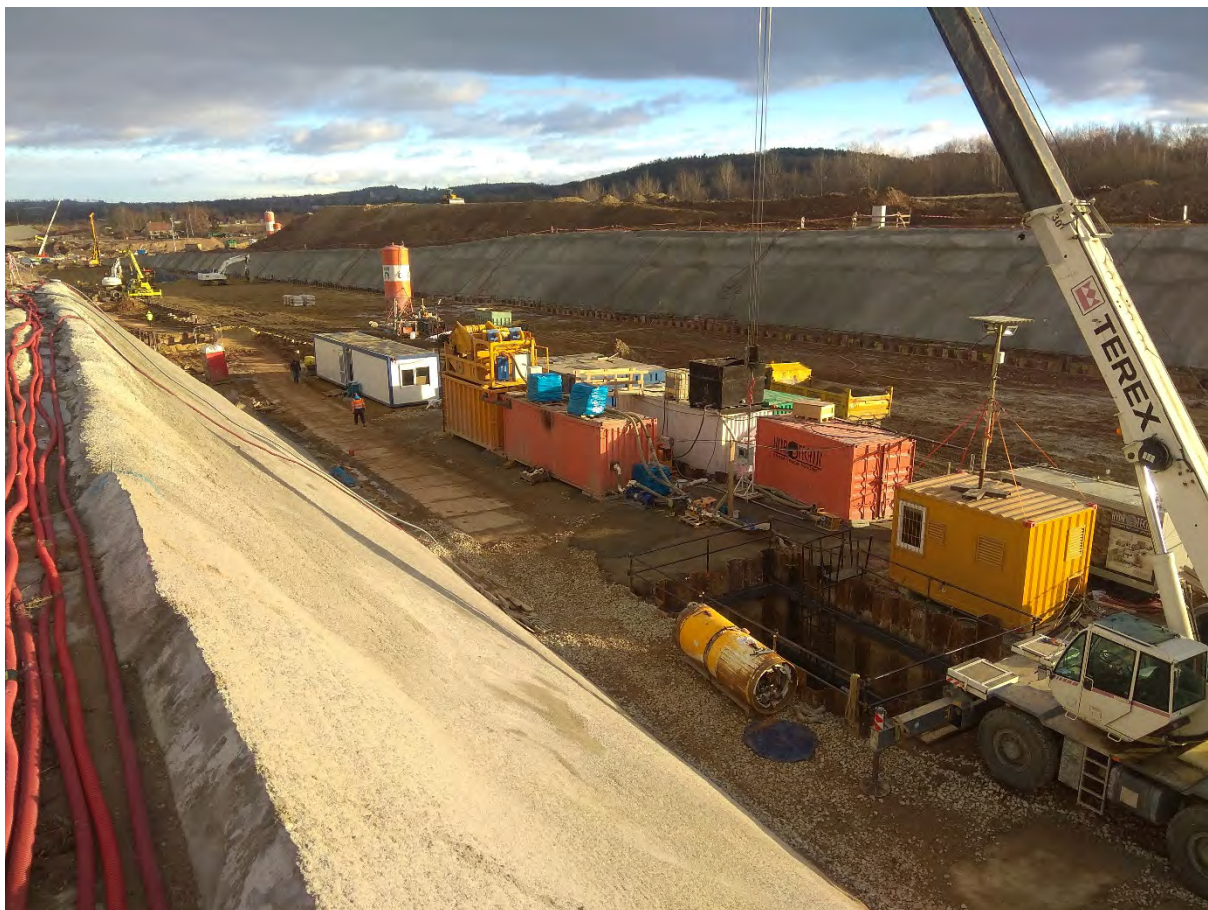
6. Pohled na zařízení staveniště u SŠ163 (II. etapa)
