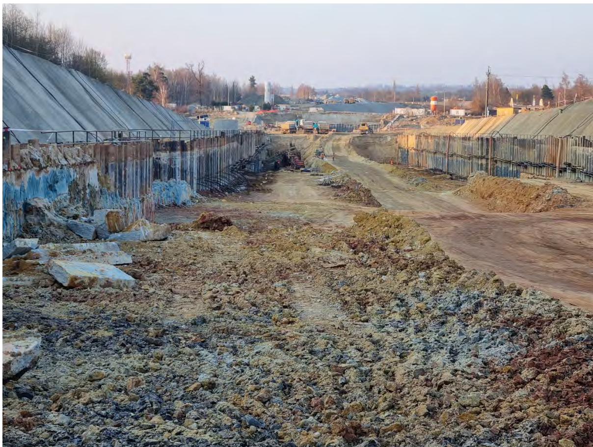
3. Pohled do hloubené části tunelu, geologické prostředí zvětralých jílovců a pískovců
