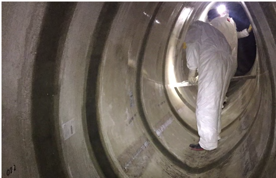
Renovace komory s použitím čedičových dlaždic
